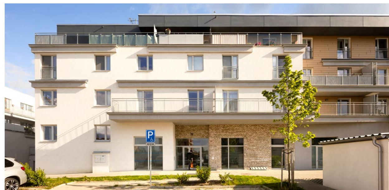
Bytový komplex, kde se nachází byt pro jednu domácnost DD
