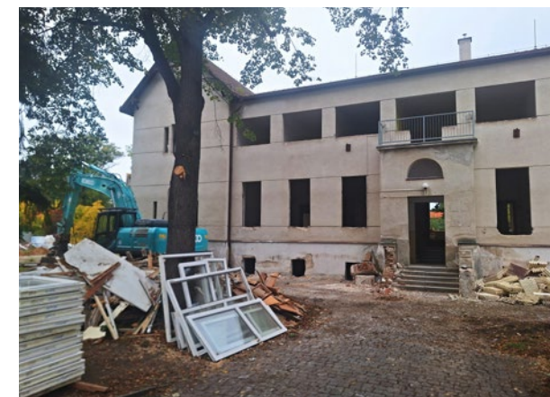
Už vystěhovaná budova DD Pardubice před demolicí
