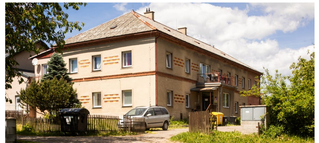
Původní budova DD Horní Čermná, nyní v majetku obce
